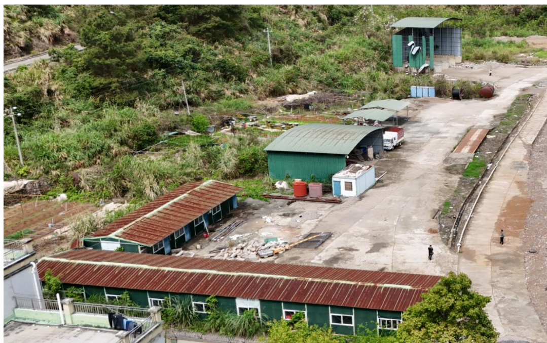
图 5.3-2 施工生产生活区航拍图
