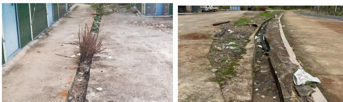
图 5.3-2 排水沟现场照片
