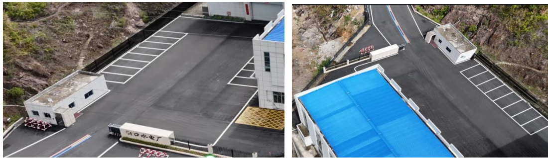
图 5.3-4 施工道路现场照片
