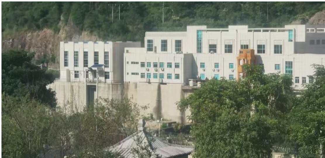
图 2.1-1 洪口水电站生态厂房照片
